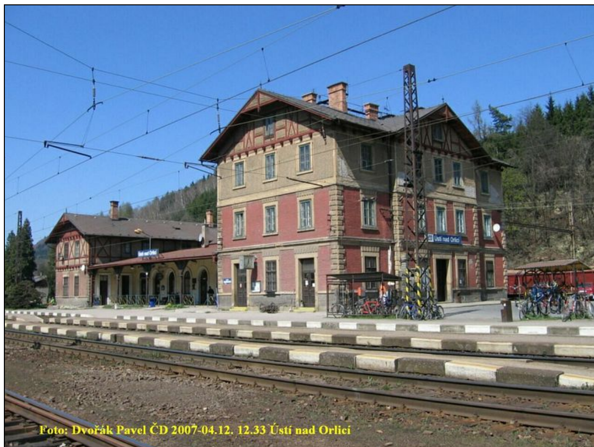
Budynek dworca w Ústí nad Orlicí, Województwo Pardubické, Republika Czeska
