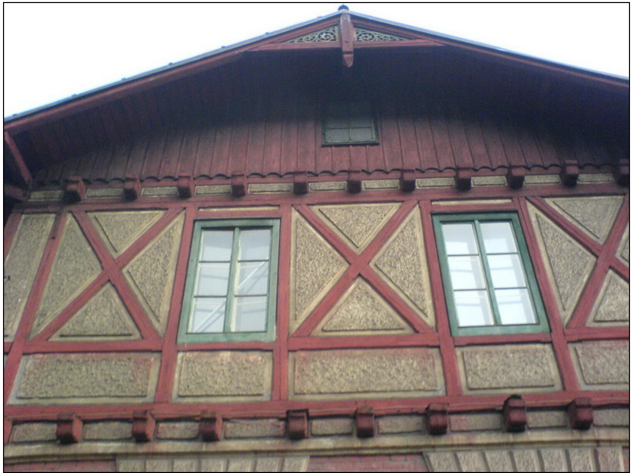
Detail budynku dworcowego w Ústí nad Orlicí, Województwo Pardubické, Republika Czeska
